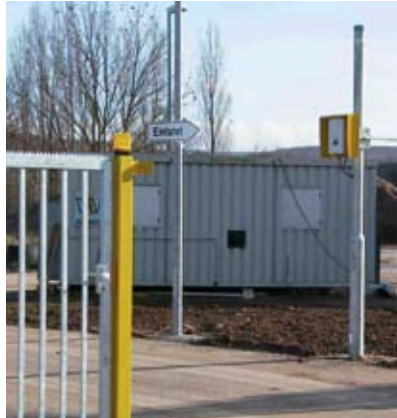
Werkzugang über Transponder-Kartenlesesystem
